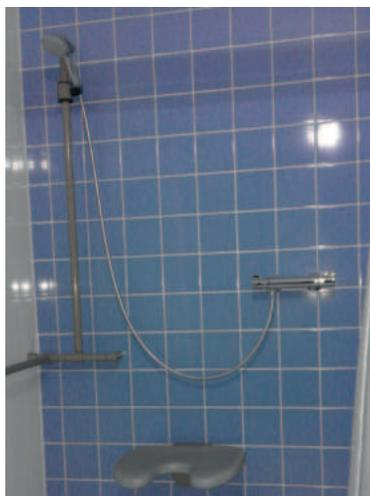
Armatur und Duschkopf befinden sich an der gleichen Wand wie der Sitz und sind somit im Rücken des Nutzers und schwer erreichbar. Die Armatur ist zudem zu hoch angebracht und der Duschkopf befindet sich in unerreichbarer Höhe.
