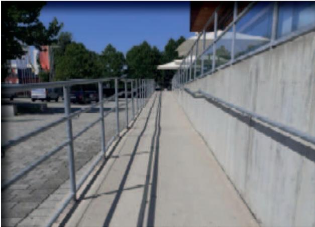
Die Rampe ist mit einer Steigung von 3,5 % mühelos befahrbar und ist zudem mit Zwischenpodesten zum Ausruhen, Radabweisern am Geländer sowie Handläufe auf beiden Seiten ausgestattet.
