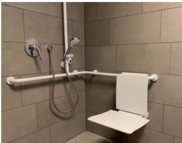
Duschsitz und Armatur sind über ein Eck im rechten Winkel angebracht, die Armatur und der Duschkopf sind somit im Sitzen gut zu erreichen. Der Duschsitz ist seitlich zu verschieben und der Haltegriff kann zur Sitzstabilität genutzt werden.
