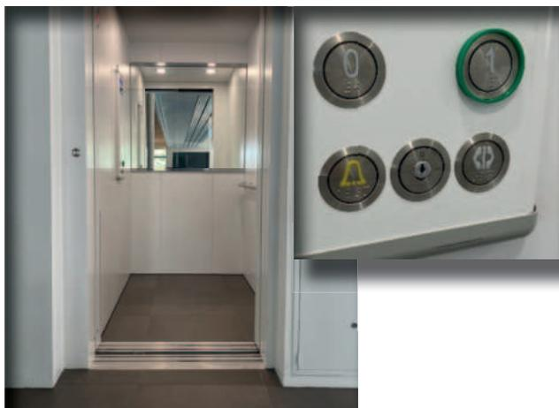
Die Tür ist ausreichend breit, der Fahrkorb ausreichend groß. Die Bedienelemente sind mit Brailleschrift versehen, zusätzlich gibt es eine akustische Ansage (Zwei-Sinne-Prinzip). An der Rückwand des Aufzugs befindet sich ein Spiegel – so kann die\*der Rollstuhlfahrer\*in vor dem Verlassen des Aufzugs sehen, ob jemand vor der Türe steht.
