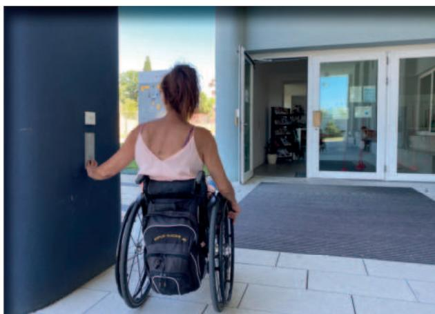
Die Türe öffnet sich automatisch – es ist kein Kraftaufwand erforderlich. Der elektrische Türöffner auf Knopfdruck ist in entsprechender Entfernung angebracht, damit die Türe nach außen öffnen kann.
